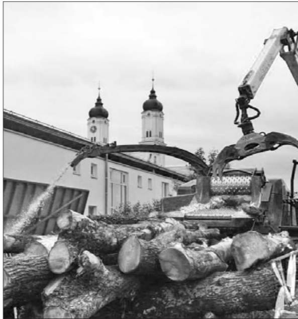
Aus Holz wird Wärme: Während des „Marktes der Möglichkeiten“ wurde der Bunker des Holzhackschnittel-Kraftwerks am Kloster Roggenburg gefüllt. Auch die Gemeinde profitiert davon: Bürgermeister Franz-Clemens Brechtel und Pater Gilbert unterzeichneten den Anschluss der Kommune an das klösterliche Energienetz. Fotos: Patrick Fauß
